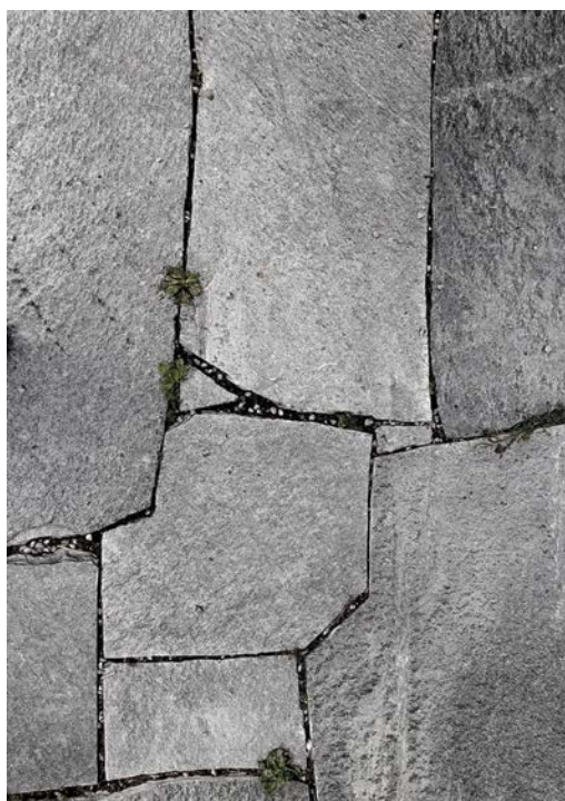
Zdjęcie 3.3.3 Nawierzchnia z łamanego kamienia
