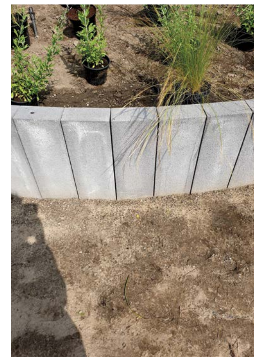
Zdjęcie 3.3.8 Palisada betonowa
