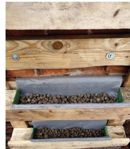
Zdjęcie 8.1.10 Wypełnienie keramzytem
