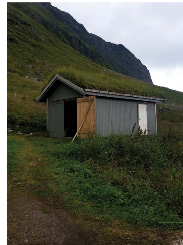
Zdjęcie 5.2.3 Zielony dach na budynku gospodarczym
