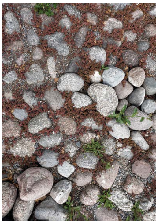
Zdjęcie 3.3.4 Nawierzchnia z otoczków
