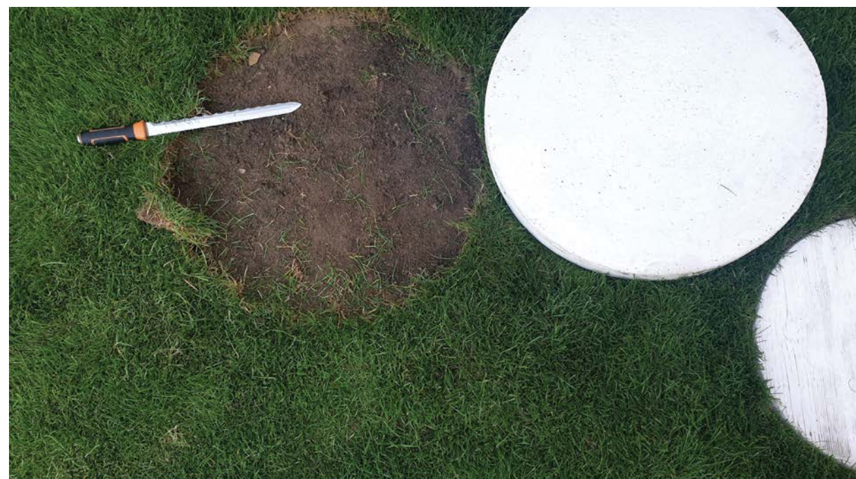
Zdjęcie 8.2.2 Wycięcie trawnika pod płyty
